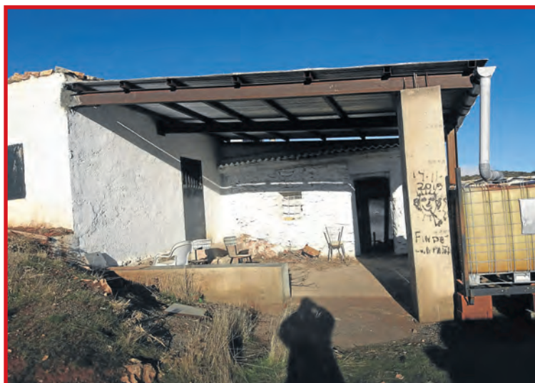
Fachada principal del inmueble tras los trabajos de acondicionamiento.
