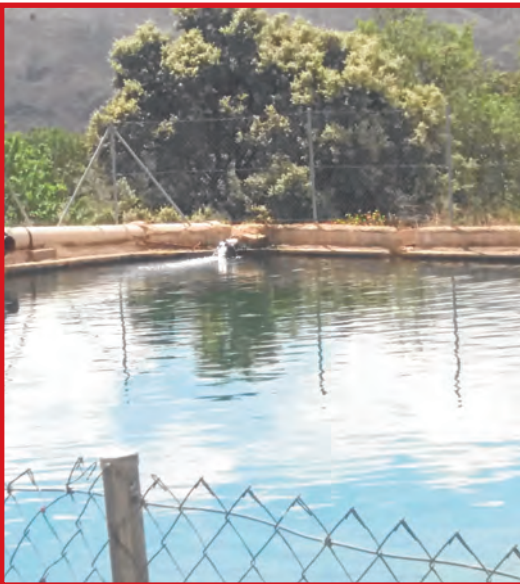
Balsa principal que abastece de riego por goteo a la vega.
