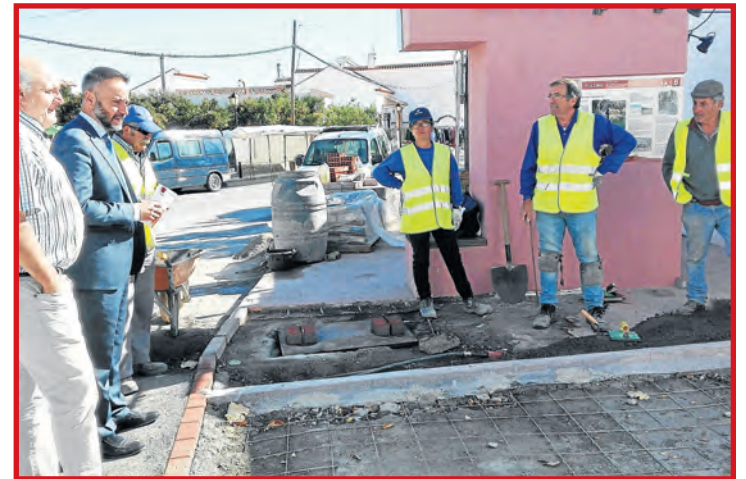
Visita de autoridades a una de las obras con trabajadores del PFEA.
